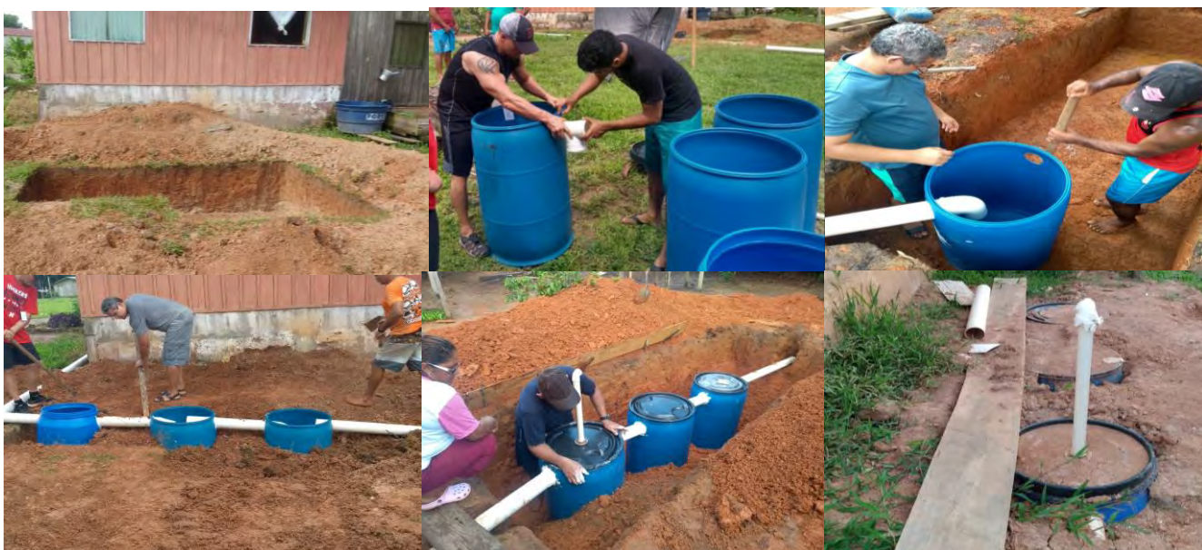
Figura 6: Instalação da Fossa Séptica Biodigestor. Fonte: Grupo Inter-Ação, 2019.
