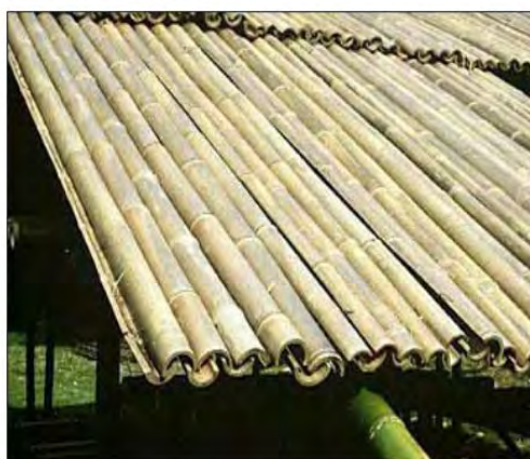
Figura 5 – Telhas tipo capa canal
