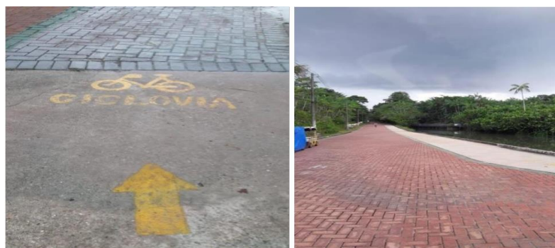
Figura 10 - Início (à esq.) e extensão (à dir.) da ciclovia.
