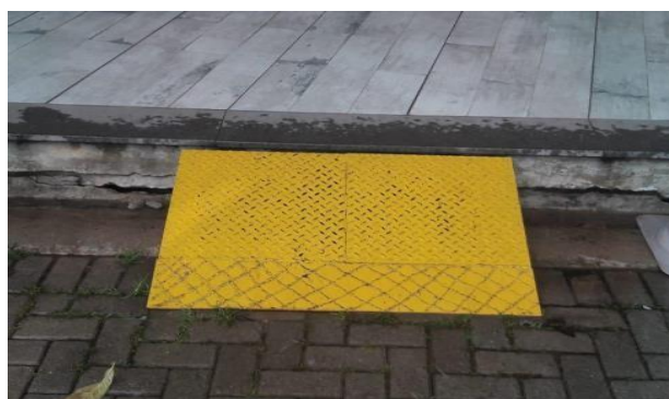
Figura 4 - Rampa de acesso
