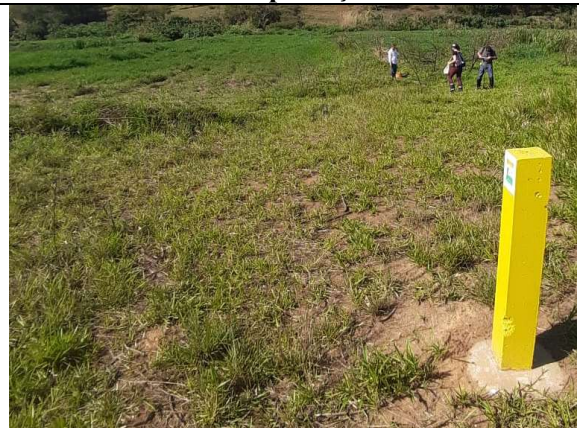
Faixa recentemente aberta por maquinário para implantação de linha de gasoduto.
