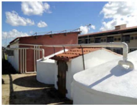
Figura 1 – Sistema captação telhados.
