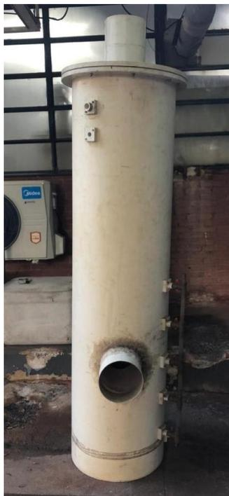
Figura 1. Coluna de absorção de leito recheado.
