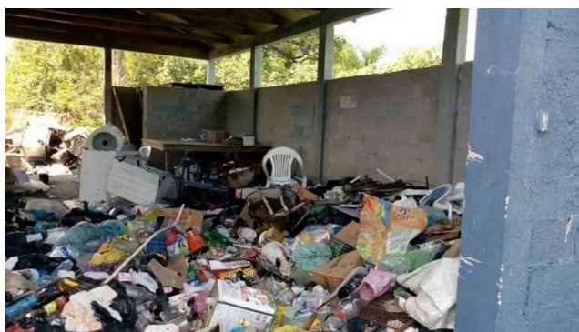
Figura 4: Galpão de rejeitos
