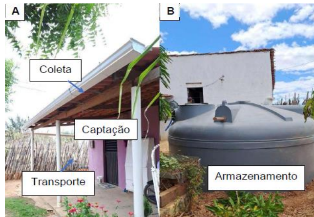
Figura 9. Sistema de aproveitamento de água de chuva. Fonte: (Pontes, 2023)
