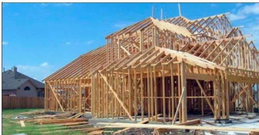
Figura 2 - Visualização da estrutura do sistema construtivo em wood frame.
