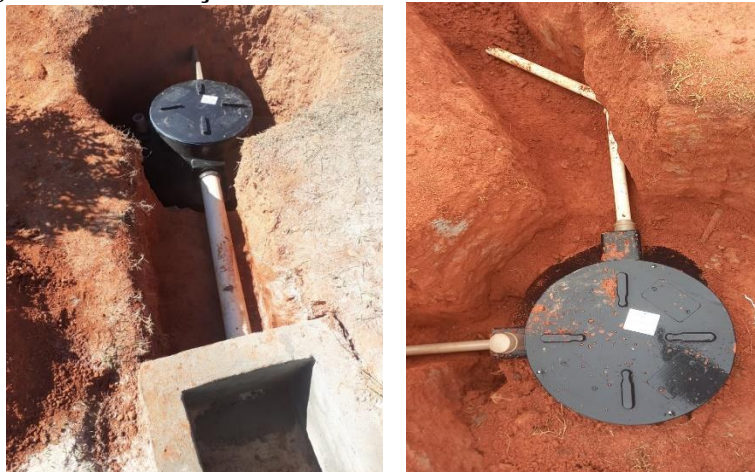
Figura 5 - Instalação do reator anaeróbico de fluxo ascendente
