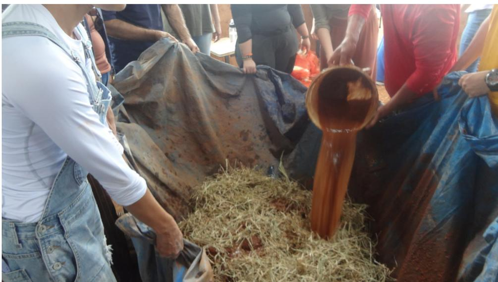
Figura 5 – Mistura de terra, água e palha de arroz. Fonte: Arquivo pessoal, 2023.
