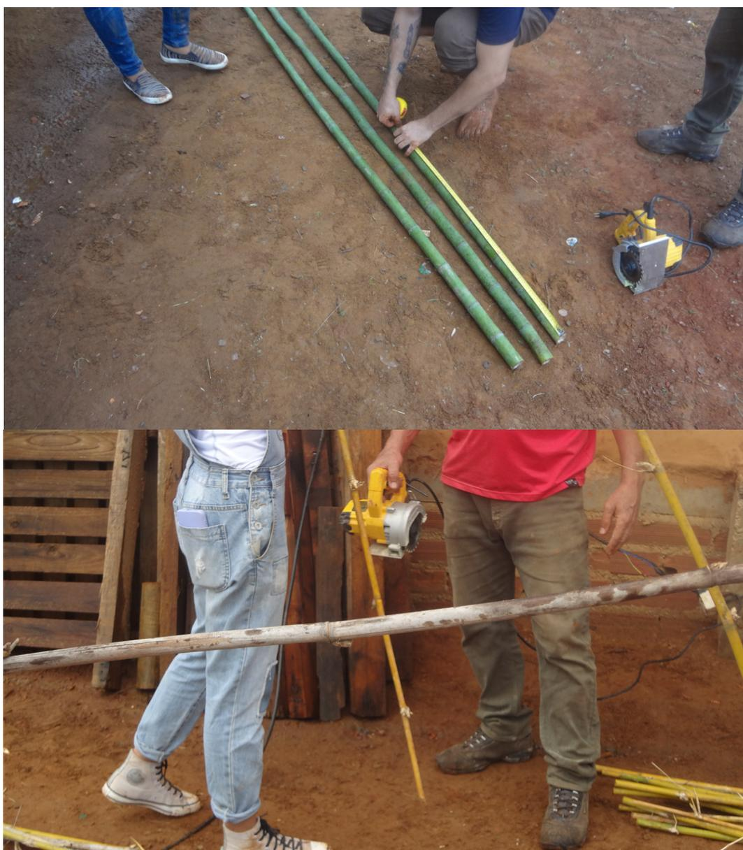
Figura 2 – Bambus seleccionados e medidos para serem cortados por máquina de corte, visando melhor acabamento. Fonte: Arquivo pessoal, 2023.
