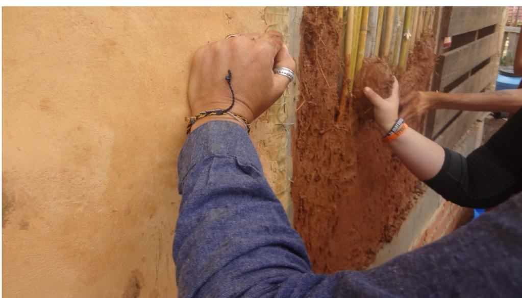
Figura 11 – Quincha recebendo uma camada da mistura feita (Proteção extra).
