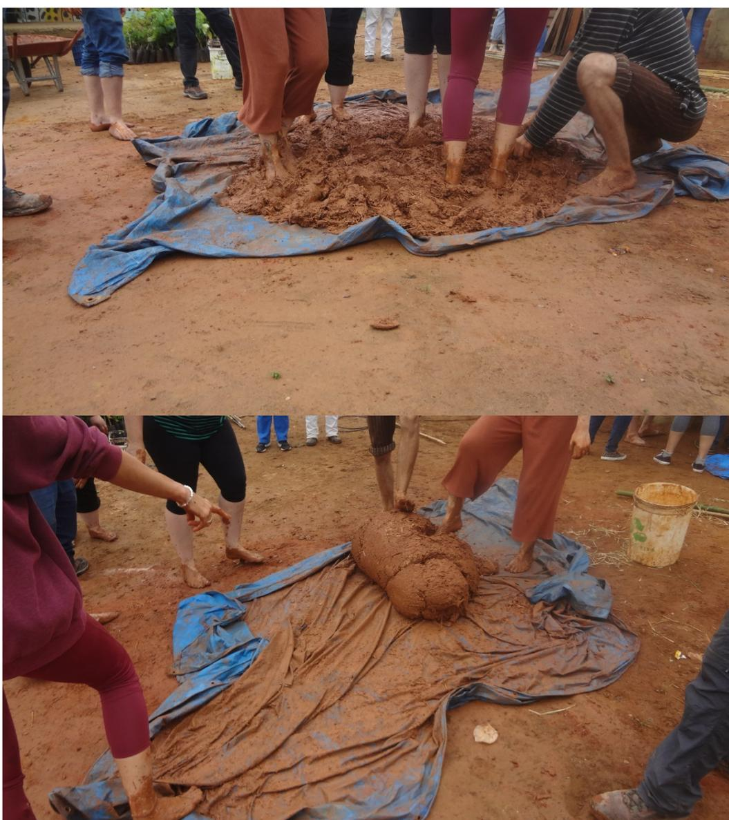
Figura 7 – Composto de terra, água e palha de arroz sendo apurado e prensado por pés e mãos dos participantes. Fonte: Arquivo pessoal, 2023.
