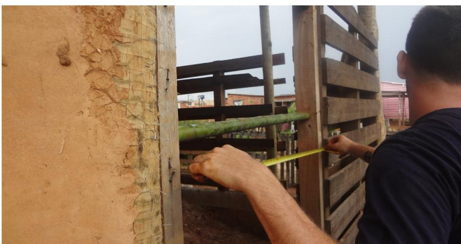
Figura 4 – Primeiros bambus inseridos na horizontal para formar a quincha.
