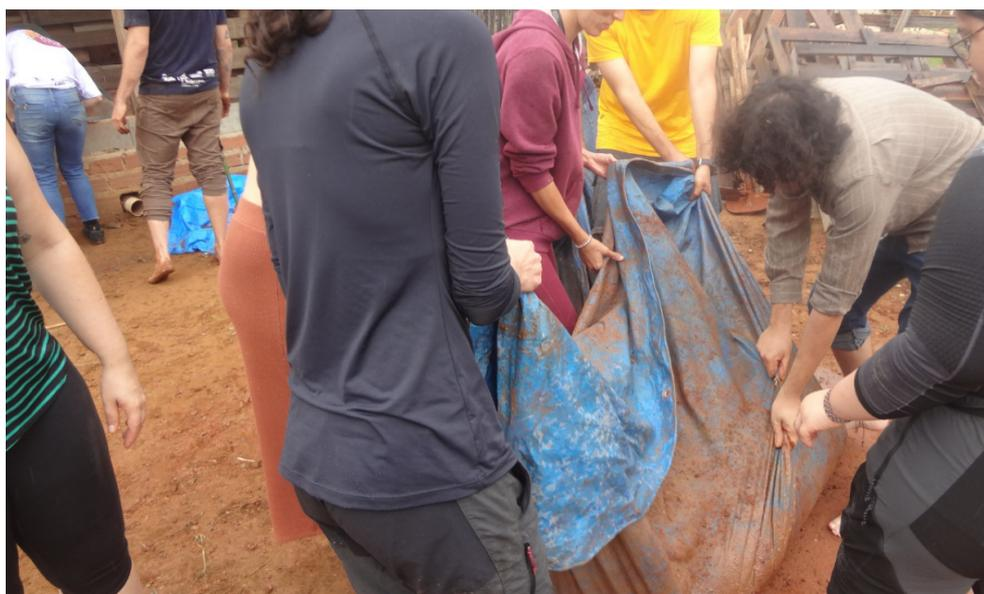
Figura 6 – Lona sendo movimentada de um lado para outro a fim de otimizar a mistura. Fonte: Arquivo pessoal, 2023.
