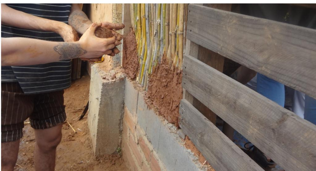
Figura 10 – Vedação da parede de quincha sendo feita com as mãos.
