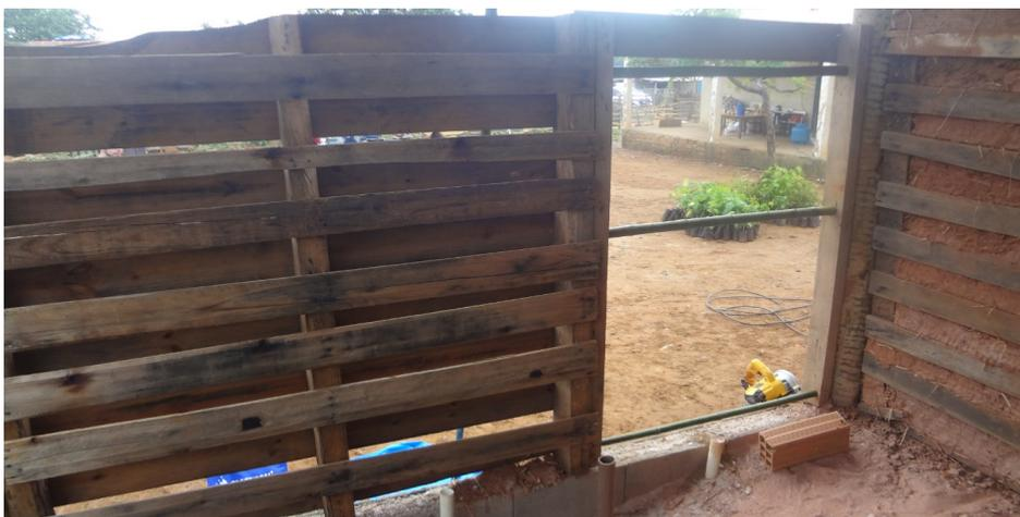
Figura 3 – Base da estrutura da quincha formando uma moldura de pallets.
