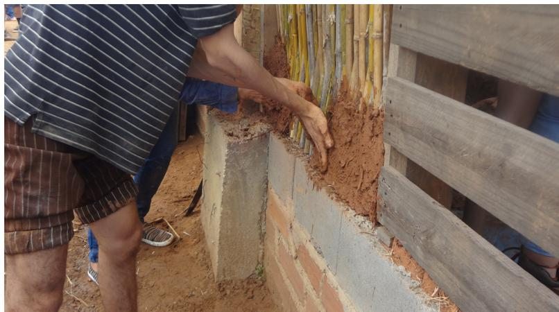
Figura 9 – Composto sendo aplicado para revestir a quincha. Fonte: Arquivo pessoal, 2023.
