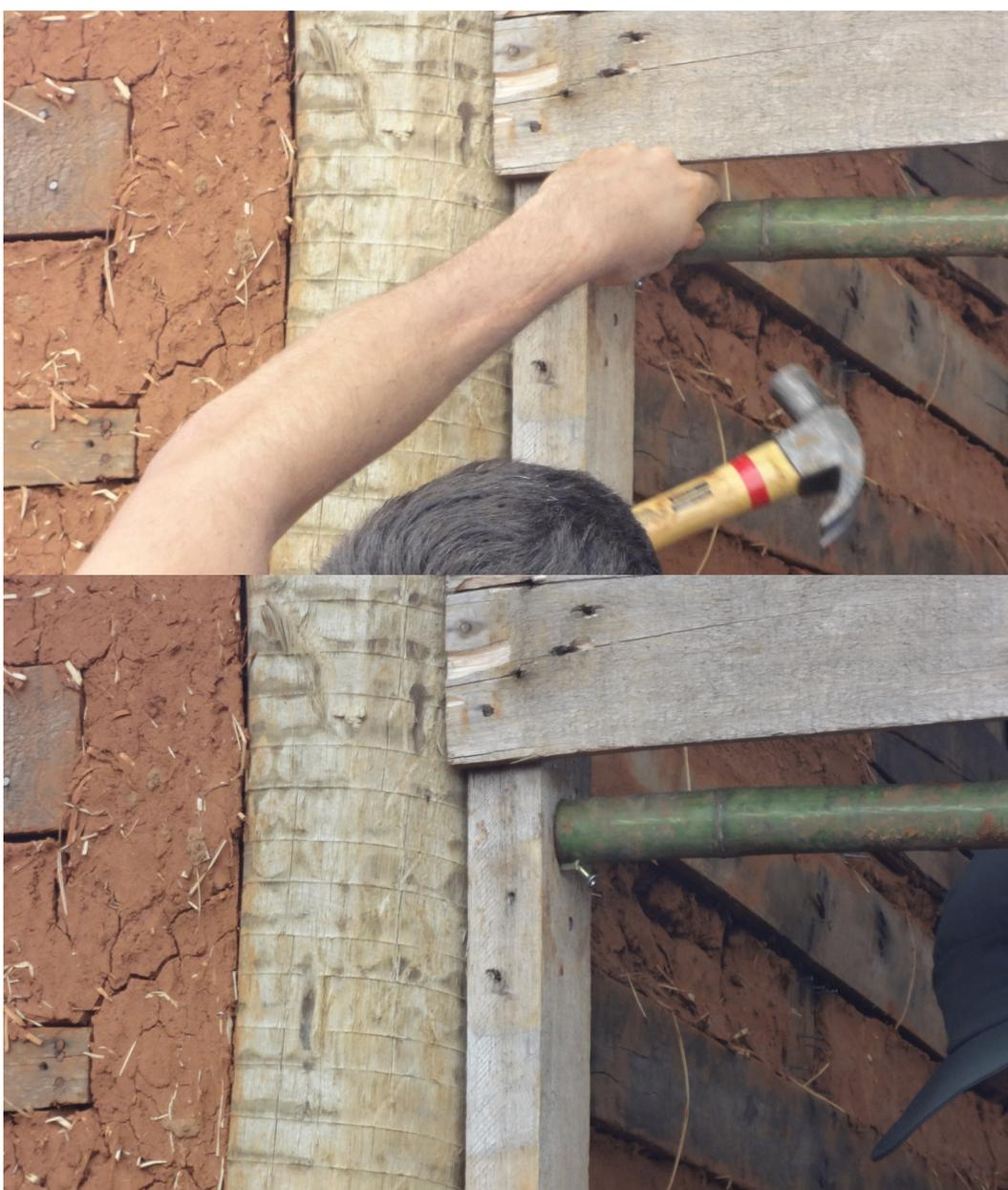
Figura 5 – Estrutura com pallets e bambus. Pregos sendo fixados, promovendo mais estabilidade para receber a trama de bambu. Fonte: Arquivo pessoal, 2023.
