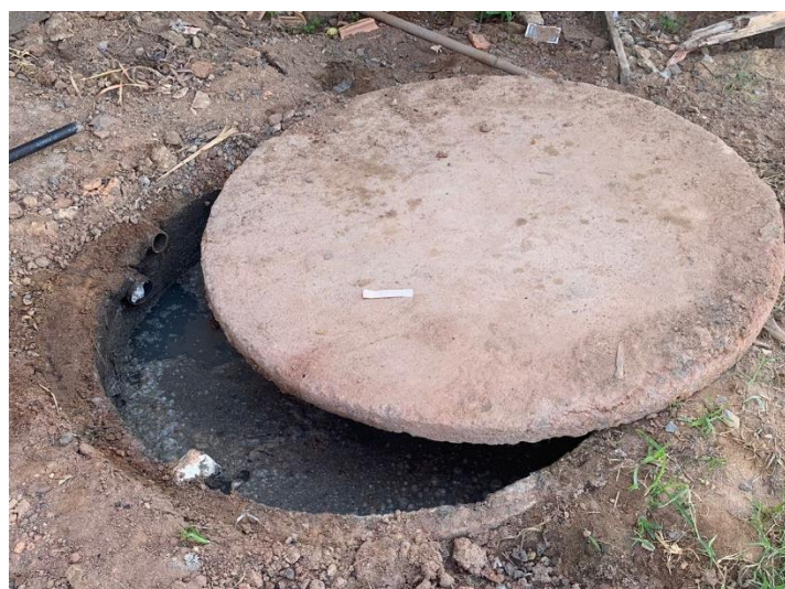
Figura 4 - Sistema para tratamento de águas cinzas
