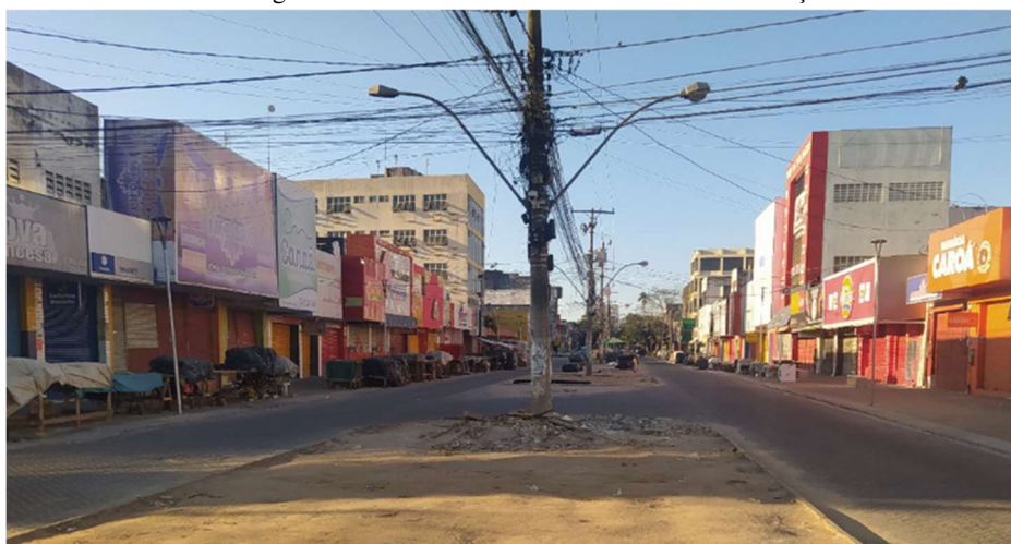
Figura 14 - Rua Marechal Deodoro obra em finalização
