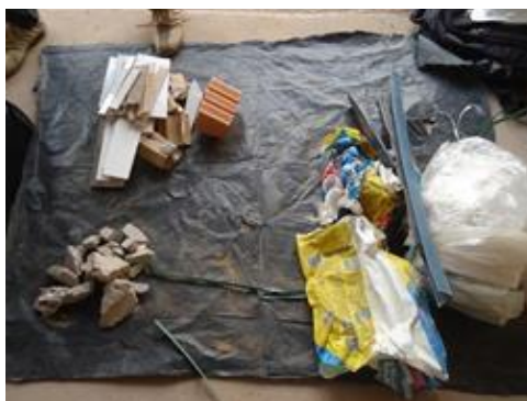
Figura 4. Classificação RCC - Obra 2. Fonte: Autor, 2023.
